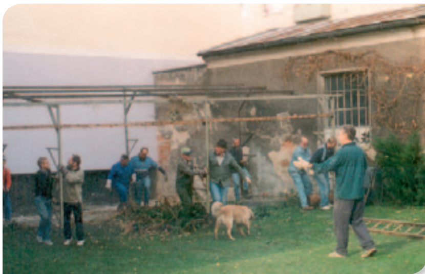
Abtrag des alten Schuppens
