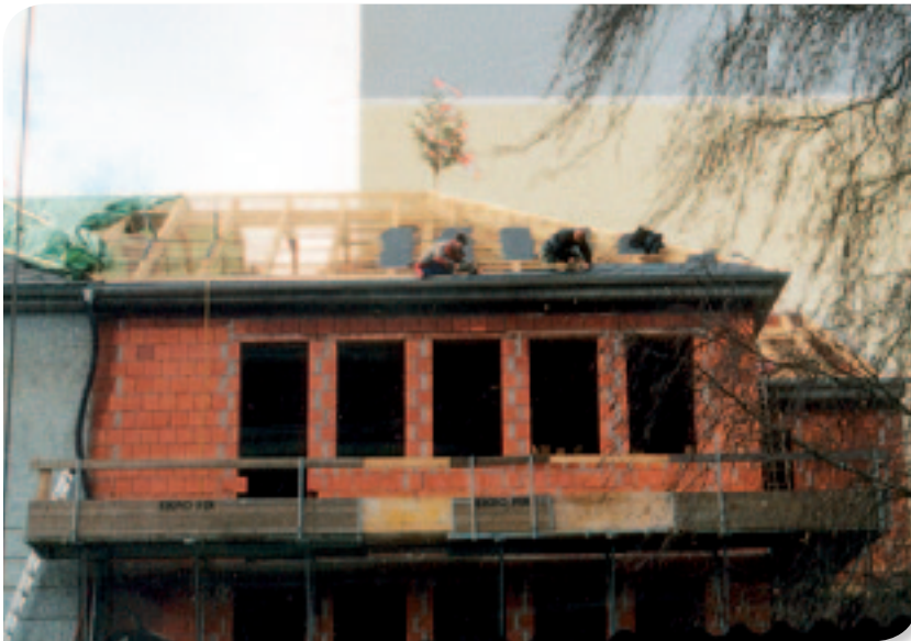
Der Rohbau ist fertig
